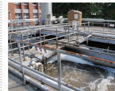
2004.5.26 污水處理場管理室完工
