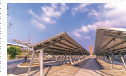
2021.12.6 第一機車停車場完工啟用
