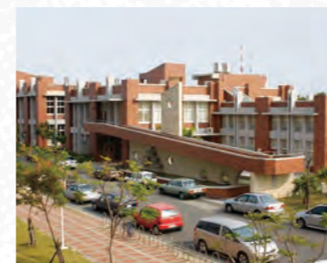
2003.8.26 土開實習工場及游藝樓完工
